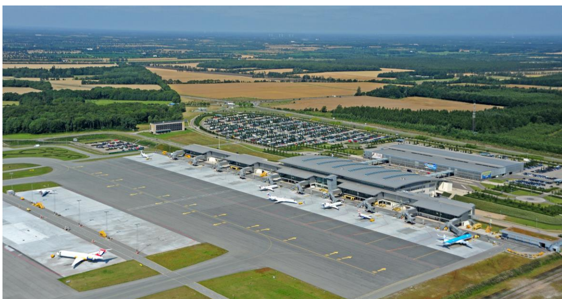
Terminalbygningen og forplads set fra sydøst.
